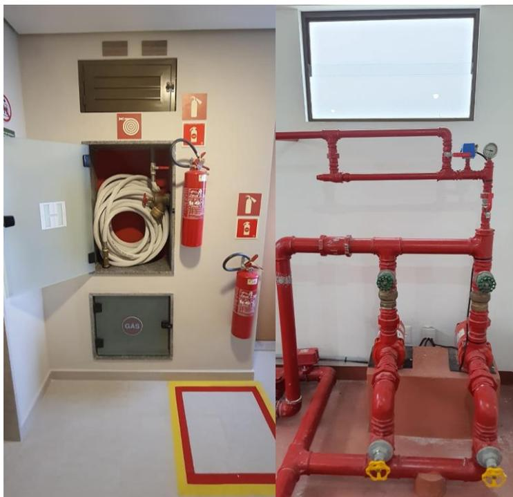
Figura 45 - Sistema de combate a incêndio (hidrante e bombas de incêndio)
