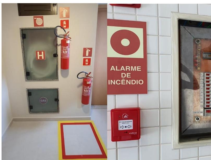
Figura 47 - Sistema de combate a princípio de incêndio (extintores e alarme de incêndio)
