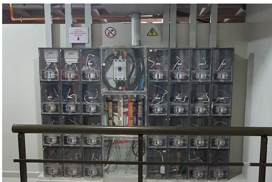
**Figura 28 - Medidores elétricos**
