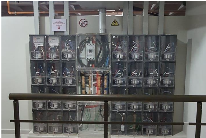
Figura 29 - Medidores elétricos
