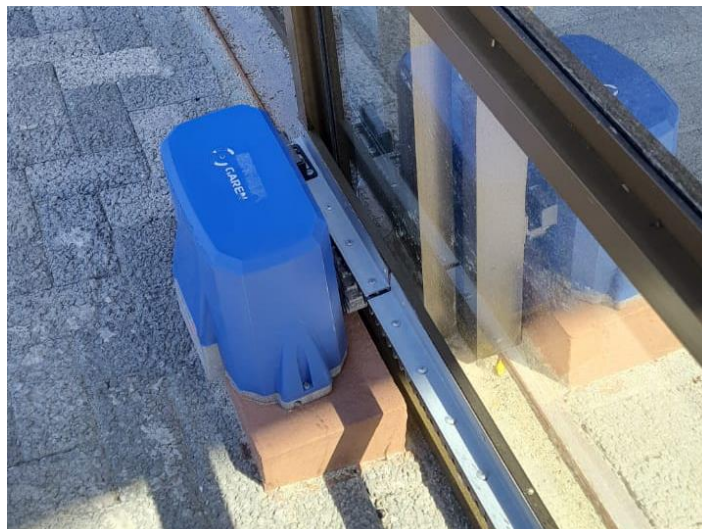
Figura 44 - Automação nos portões de acesso de veículos
