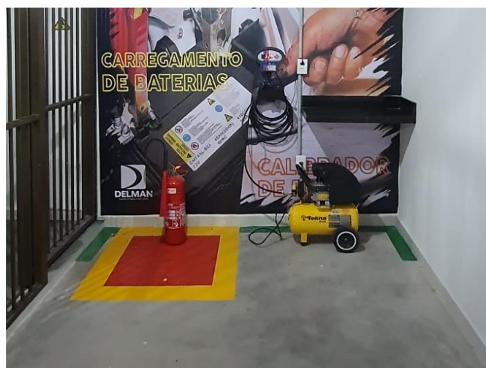
Figura 40 - Piso em concreto
