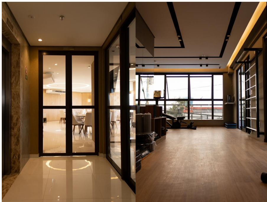
Figura 41 - Portas e esquadrias de alumínio
