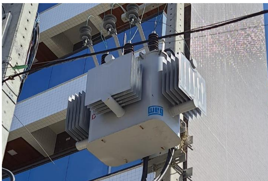
Figura 33 - Transformador elétrico
