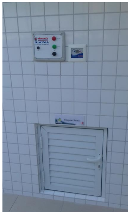
Foto 12 – Gerador de vapor com suas lâmpadas de sinalização. Não ligar enquanto a Lâmpada vermelha estiver acesa.
