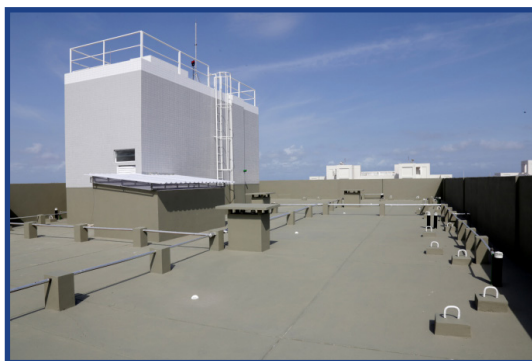
Laje da cobertura
